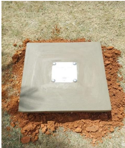
Figura 1 - Marco de referencia construido.
