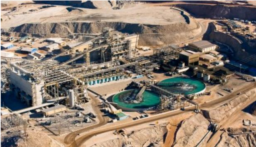
Planta de tratamiento de agua en la mina Cerro Verde, Perú
